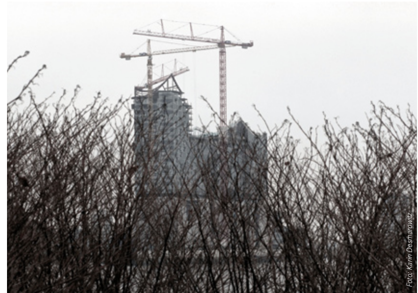
Baustelle Elbphilharmonie vom südlichen Elbufer
