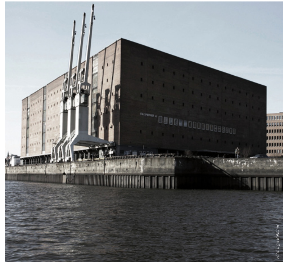
Kaispeicher A im Frühjahr 2005
