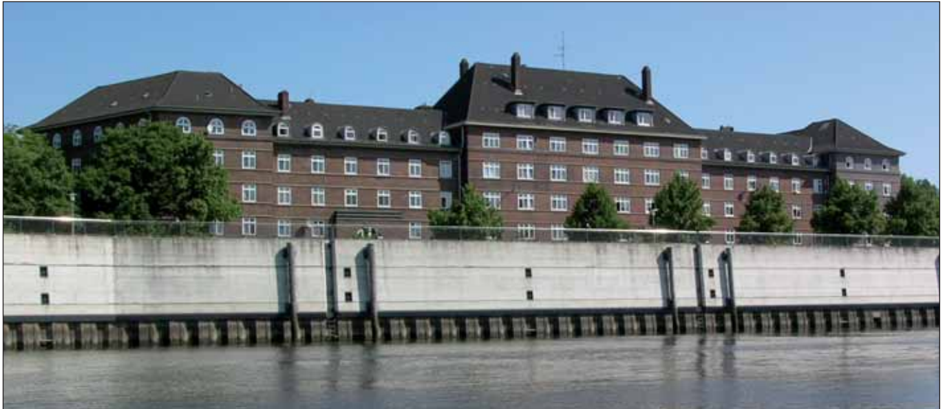
Wohnblock auf der Veddel
