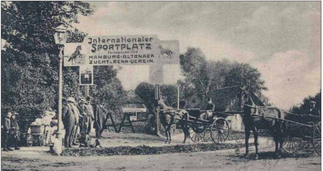
Als in Hamburg noch Pferde gezüchtet wurden
