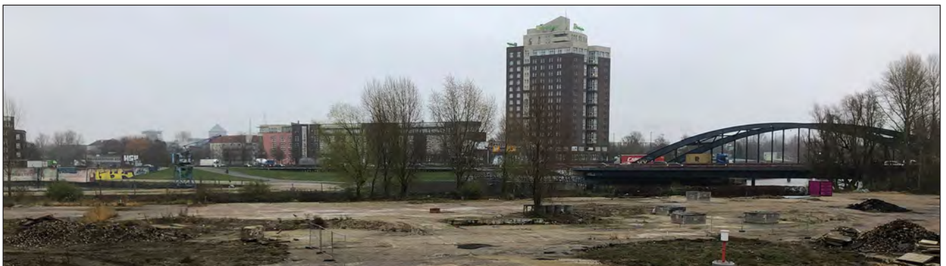
Elbtower-Baugelände, 11.12.2020 (Foto: Heike Sudmann)
