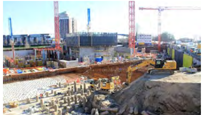
Aus Rothenburgsort schon jetzt nicht mehr übersehbar: Die Baustelle des Elbtowers
