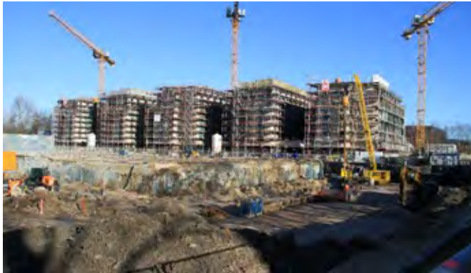
Ein Riegel mit 470 Mikroapartments schirmt das neue Wohngebiet an der Marckmannstraße vom Lärm der Bahntrasse ab
