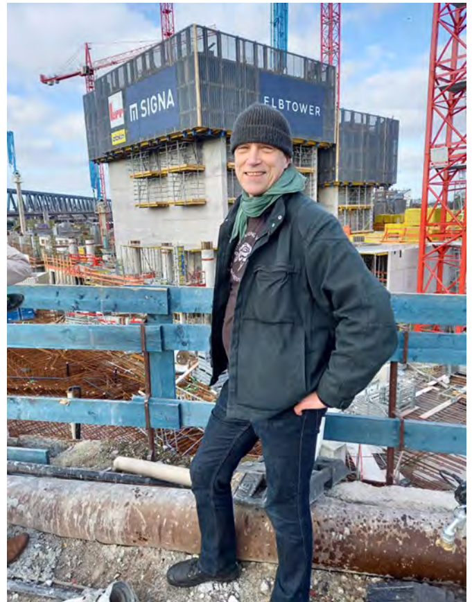
Ingo Böttcher vor der Elbtower-Baugrube (Fotos: M. Joho)
