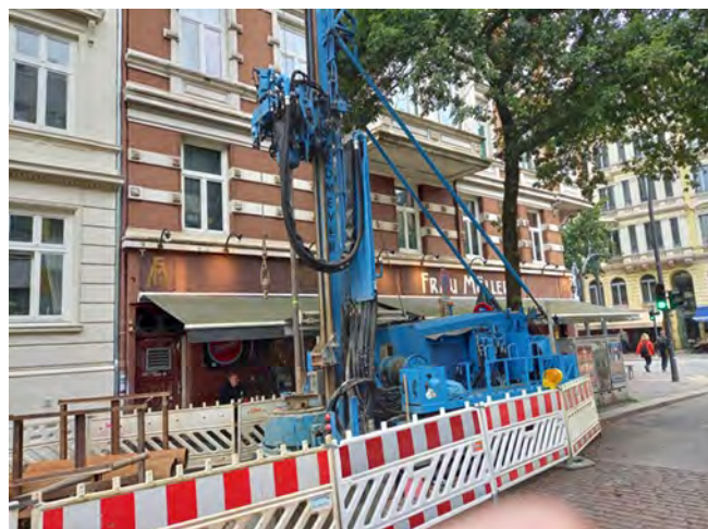
Eine von mehreren Probebohrungen für die U5 an der Langen Reihe (Foto: Michael Joho)
