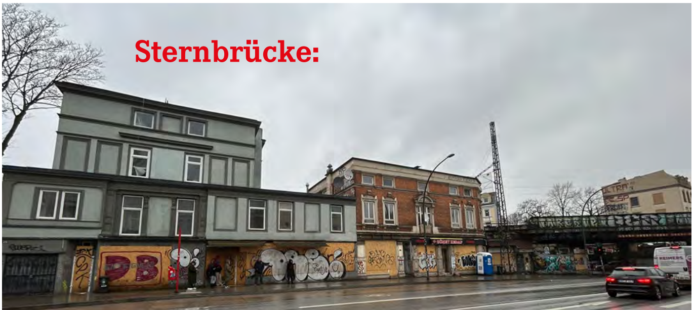
Sternbrücke vom Abriss bedroht! (Foto: H. Sudmann)
