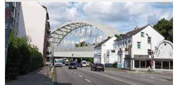
... soll durch eine gigantische Konstruktion ersetzt werden
